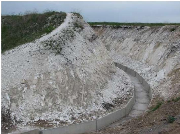
*Рисунок 2. Меловые породы турон-коньякского возраста, залегающие на поверхности в районе Острогожска, с размещённым в них водоотводящим инженерным сооружением*
